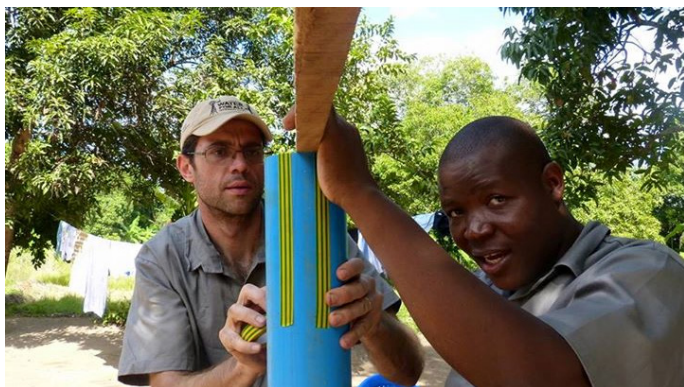
Figura 5: Pedro e Felizardo realizando a perfuração de poços (imagem retirada do veículo de comunicação do projeto Não a Nós, 2015).
