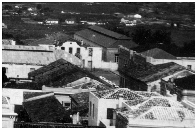
Foto nº 01. Detalhe de foto panorâmica onde mostra ao fundo a demolição da Igreja N.Sra do Rosário, 1922.
